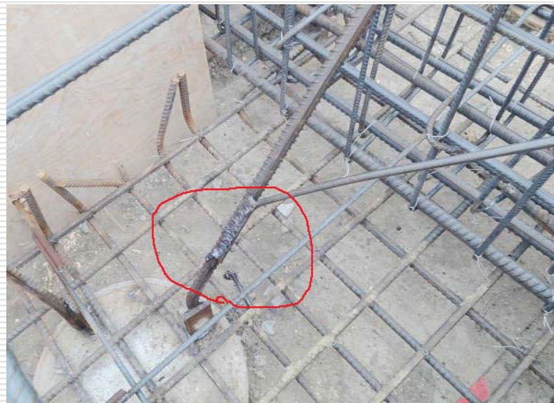
防雷引下点的焊接
