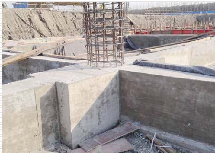
1~6轴基础混凝土浇注完成
