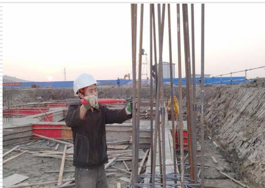
框架柱直螺纹钢筋连接
