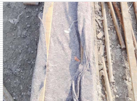
基础混凝土棉布覆盖养护
