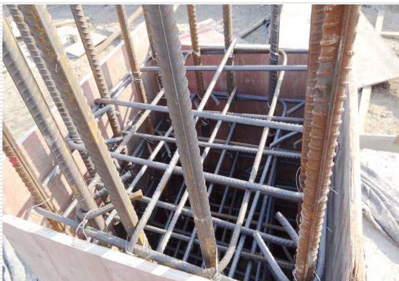
基础短柱钢筋绑扎
