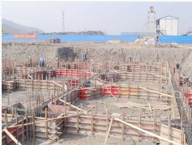
基础模板加固
