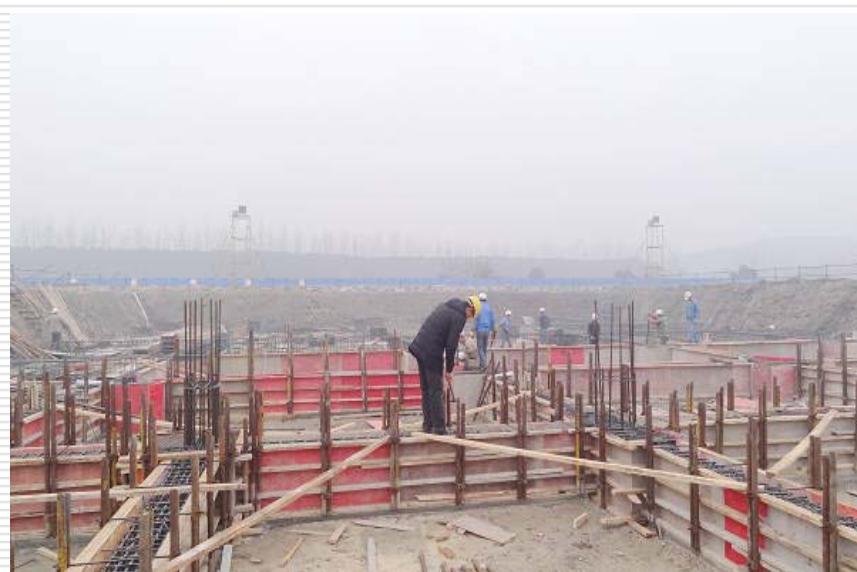
管理人员现场检查质量
