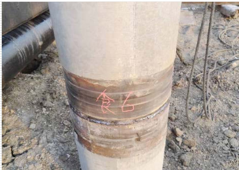
食堂管桩焊接情况
