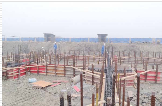
冲洗基础承台及梁模板
