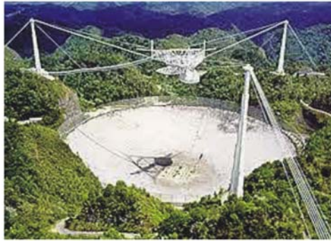
图3.26 美国Arecibo天文台固定球面射电望远镜。口径为305米，有效照明口径是213米，整个球面由40,000块大小为0.914米1.828米铝板组成，口面到球面天线顶点的距离约为50.9米，球面曲率半径为265米；工作频率从50 MHz到10 GHz；在球面天线上方是馈源系统，重达900吨，它由三组钢缆悬挂在约137米高处。
